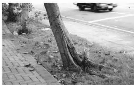
樹木傾倒的力量造成根株部位木材纖維拉扯裂傷
