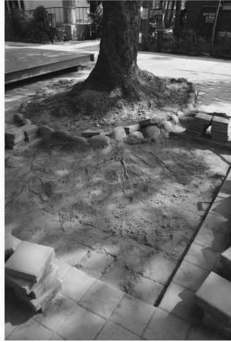
根大量生長在透水磚的下方
