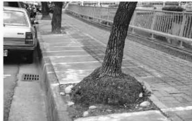
植穴太小或鋪面設置造成根株受傷而形成樹幹內部的腐朽腫大2
