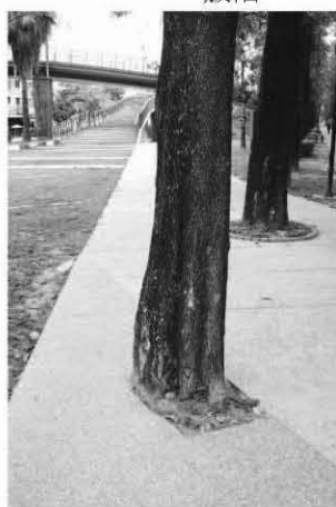
鋪面設置造成根株受傷而形成樹幹內部的腐朽腫大
