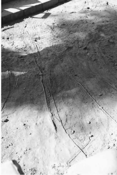
根大量生長在透水磚的下方
