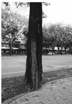
鋪面步道設置造成根株部位受傷而形成樹幹腐朽
