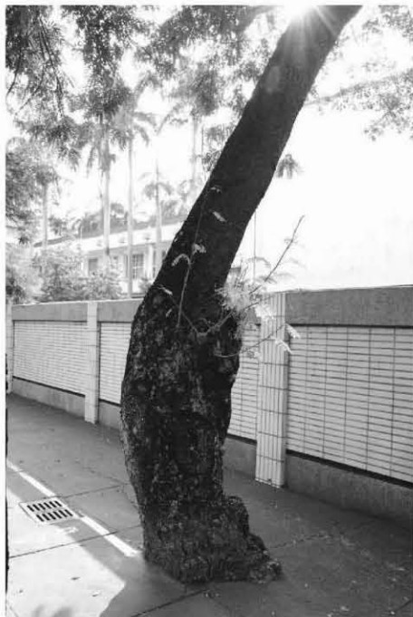
植穴太小或鋪面設置造成根株受傷而形成樹幹內部的腐朽腫大
