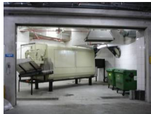
B2F垃圾壓縮室
