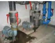
空調系統冰水泵浦更新並加裝變頻器，提高效率節省電能費用。
