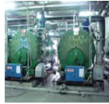
原三台4噸柴油鍋爐改為七台10噸熱泵、一台瓦斯熱水爐及兩台1噸瓦斯貫流式鍋爐，節省柴油能源費用。
