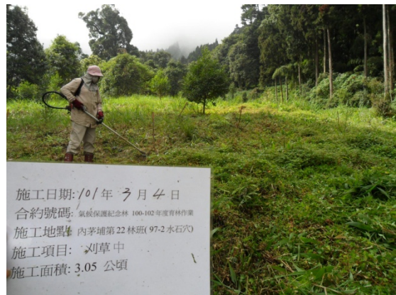
氣候保護紀念林 22 林班 97-2 造林地除草(施工中)
