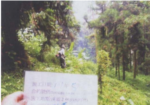
氣候保護紀念林 2 林班 97-1 造林地除草(施工中)
