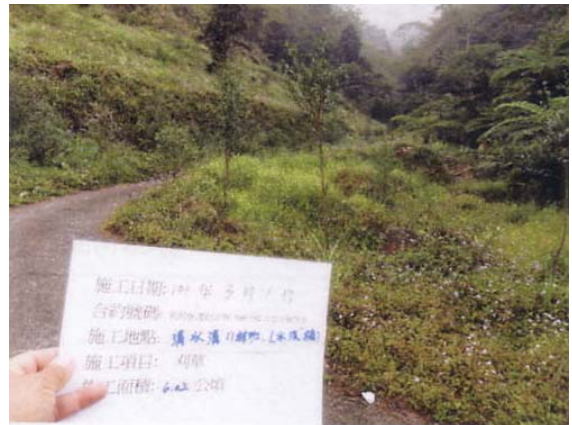
氣候保護紀念林 11 林班 97-1 造林地除草(施工前)
