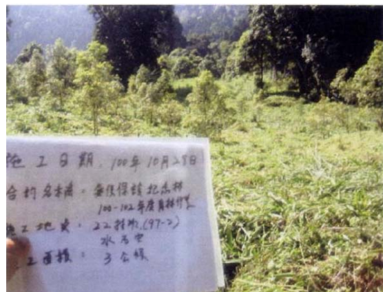
氣候保護紀念林22林班97-2造林地除草(施工後)
