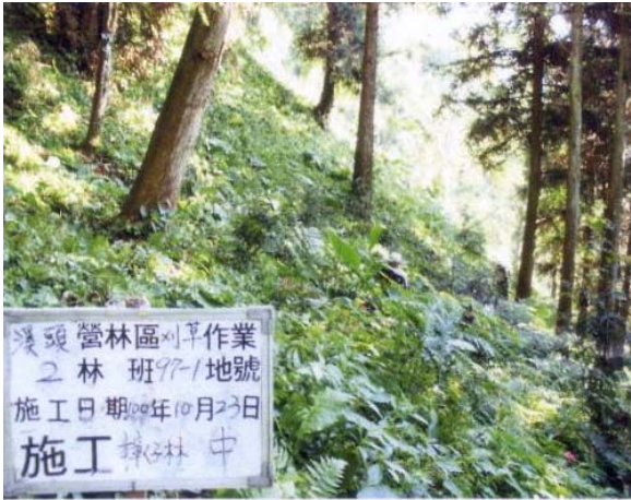
氣候保護紀念林2林班97-1造林地除草(施工中)
