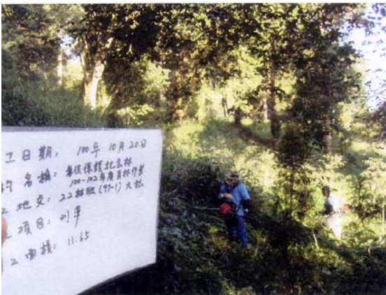
氣候保護紀念林22林班97-1造林地除草(施工中)
