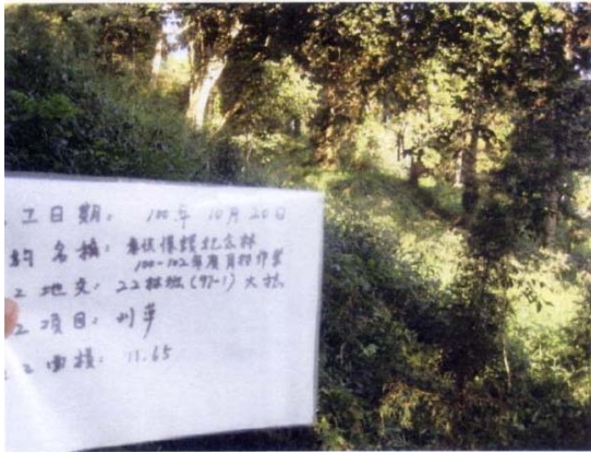
氣候保護紀念林22林班97-1造林地除草(施工前)
