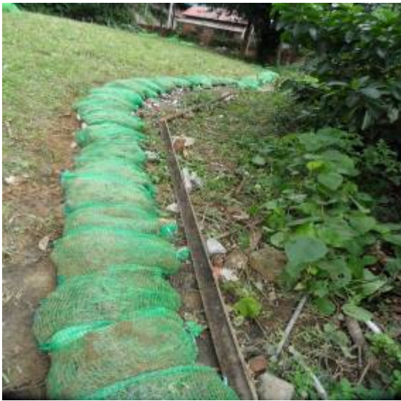
竹子與廢棄石磚搭建的排水道
